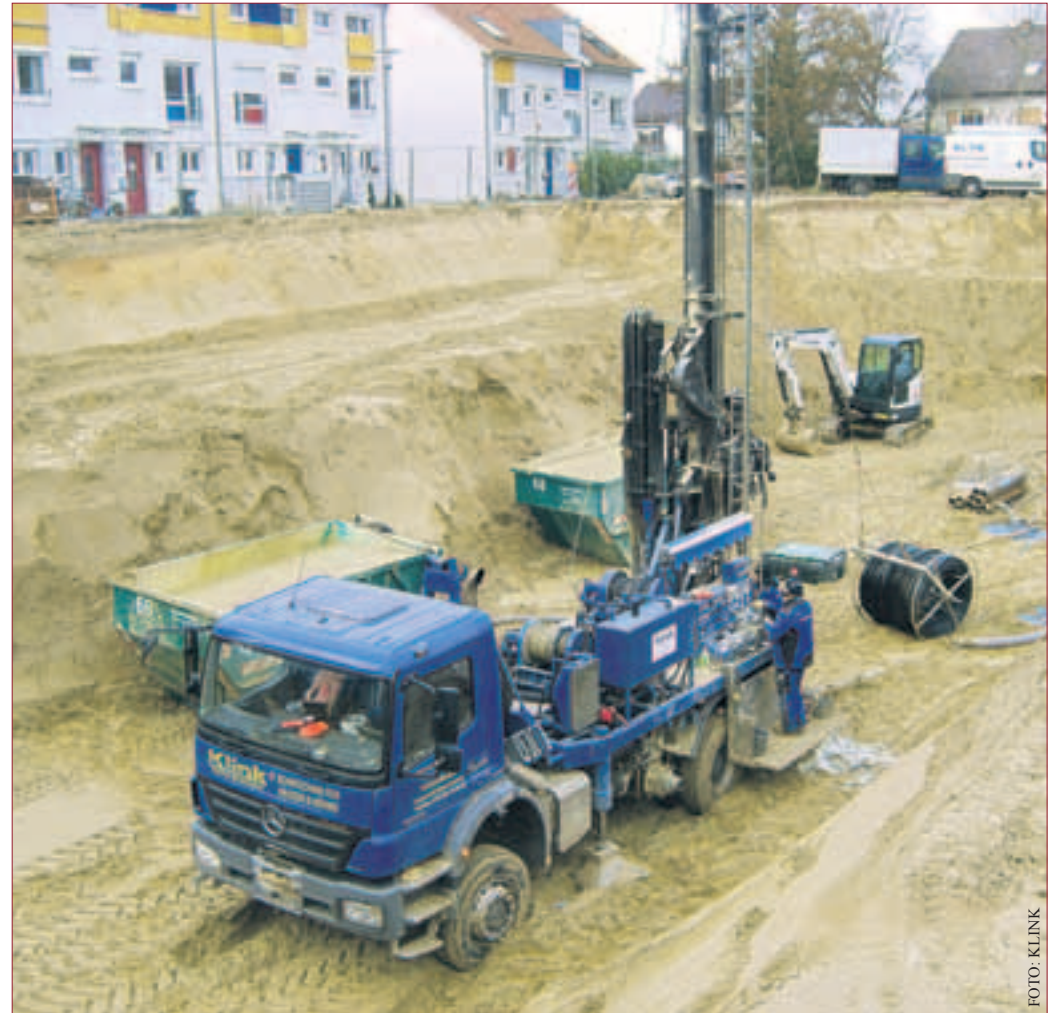
Die Firma H.D. Klink aus Worfelden ist Experte in Sachen Erdwärme und Brunnenbohrungen.
