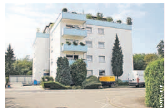
SEIT ÜBER 17 JAHREN AM MARKT: D+D hat sich auf Rohrleitungssanierung spezialisiert. Oft werden mehrere Wohneinheiten in einem Zug saniert.
