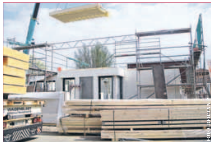
UM AUF NUMMER SICHER ZU GEHEN, sollten Baufamilien bereits die Baustelle versichern. Einige Fertighausanbieter haben die dafür notwendigen Versicherungen bereits in ihre Leistungspakete integriert. Weitere Informationen unter www.zukunft-fertighaus.de. (tsp-p)
