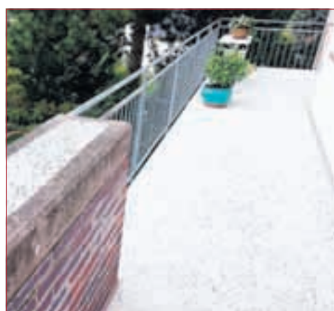
TOP SANIERTER BALKON nach Glanzner-Methode.
