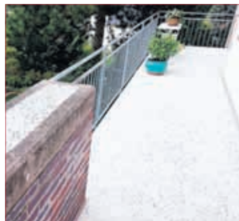
TOP SANIERTER BALKON nach Glanzner-Methode.
