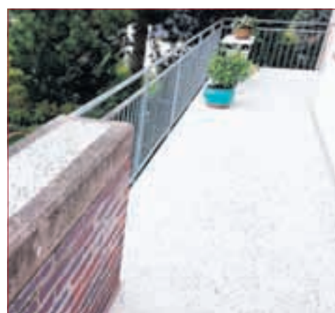
TOP SANIERTER BALKON nach Glanzner-Methode.
