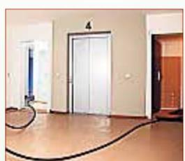
oben: Pro Stockwerk werden in diesem Objekt zwei Wohnungen an den Wasserstrang angeschlossen. links: Im D+D-Verfahren wird ein geschlossenes System erzeugt, um die Wasserleitungen zu trocknen, sandstrahlen und beschichten.
