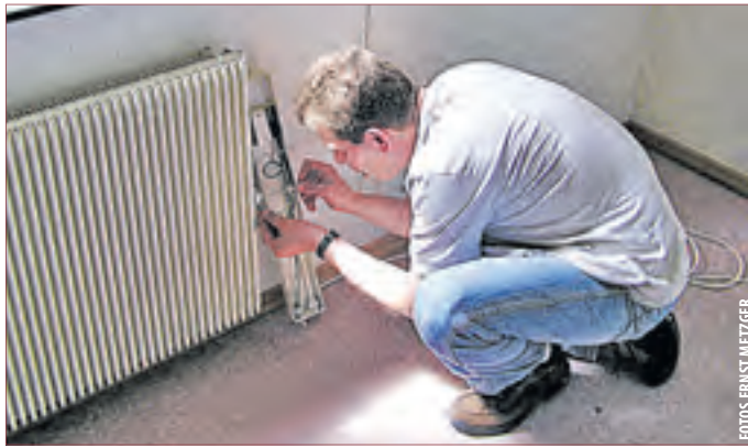
MONTAGE VOR ORT: Innerhalb eines Tages ohne Baustelle.
