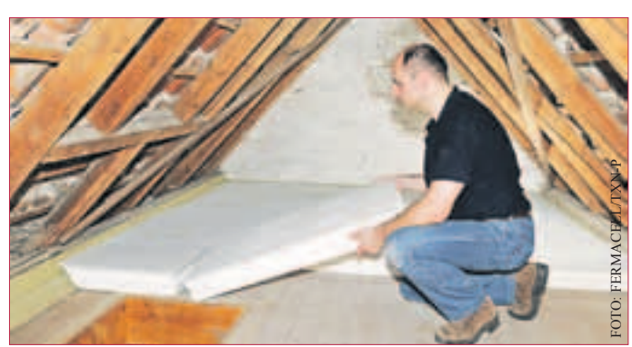
DACHBODEN-DÄMMELEMENTE mit Nut- und Federverbindung machen die Wärmedämmung der obersten Geschossdecke ganz einfach.
