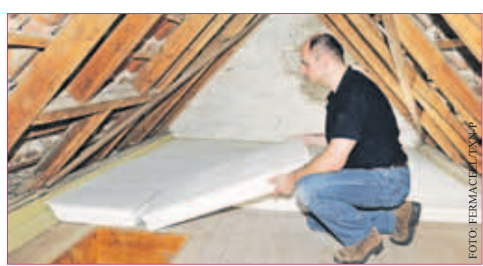
DACHBODEN-DÄMMELEMENTE mit Nut- und Federverbindung machen die Wärmedämmung der obersten Geschosdecke ganz einfach.
