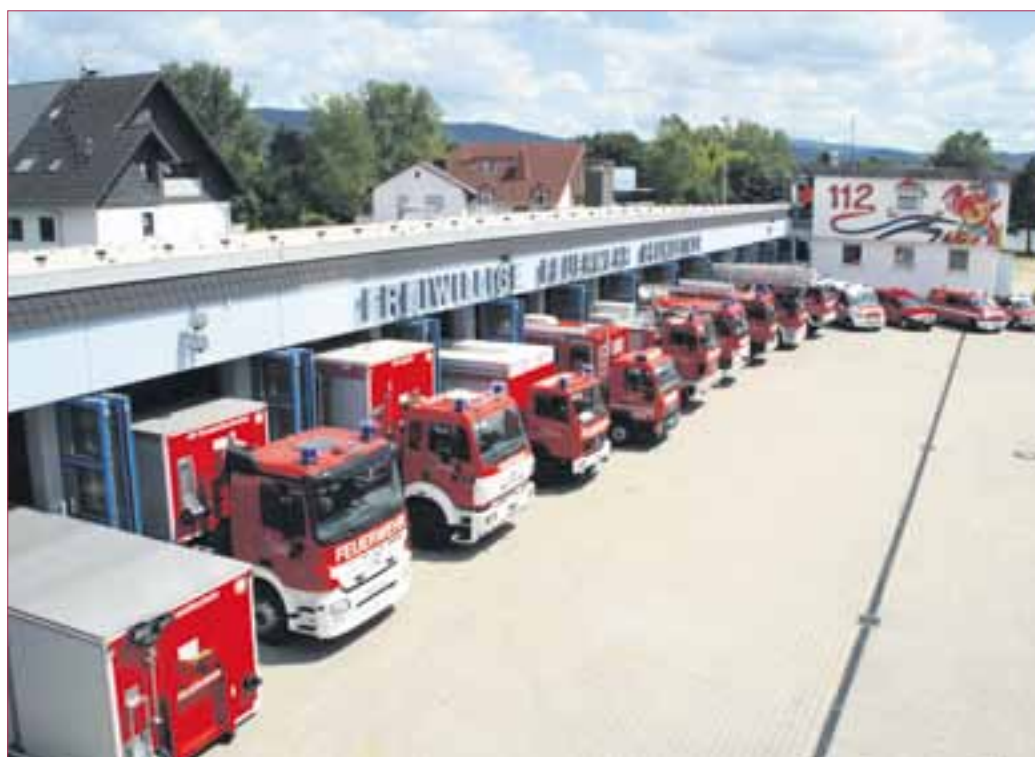
VIELFÄLTIGE AUFGABEN Der Fuhrpark der Pfungstädter Feuerwehr kann sich sehen lassen. Da ist jeder Wagen voll einsatzbereit und wird gepflegt und gewartet.
